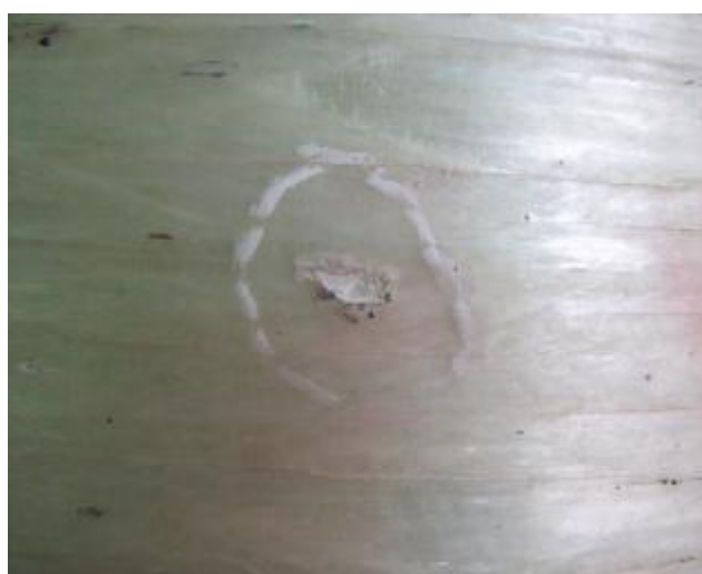
图C.6 磕碰损伤（三级损伤）
