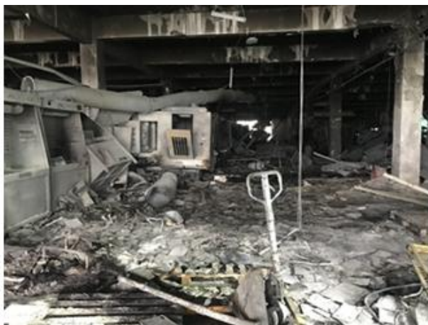
图 7 凹陷的地面楼板
