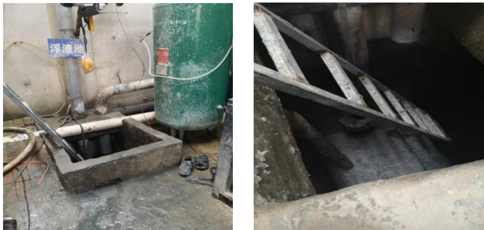
图 16 发生事故的浮渣池
