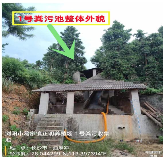
(1号粪污池整体外貌)
