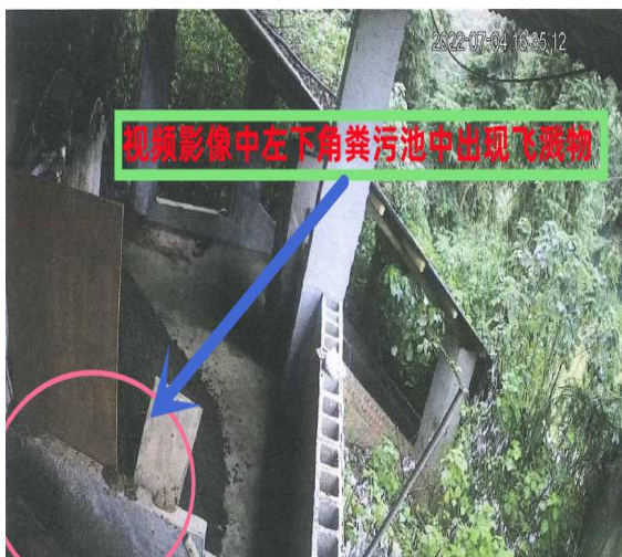
(16 时 35 分 12 秒，视频影像左下角的粪污池中出现粪污水等飞溅物)
