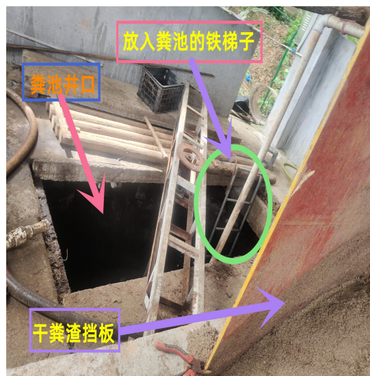
(1号粪污池井口状况)
