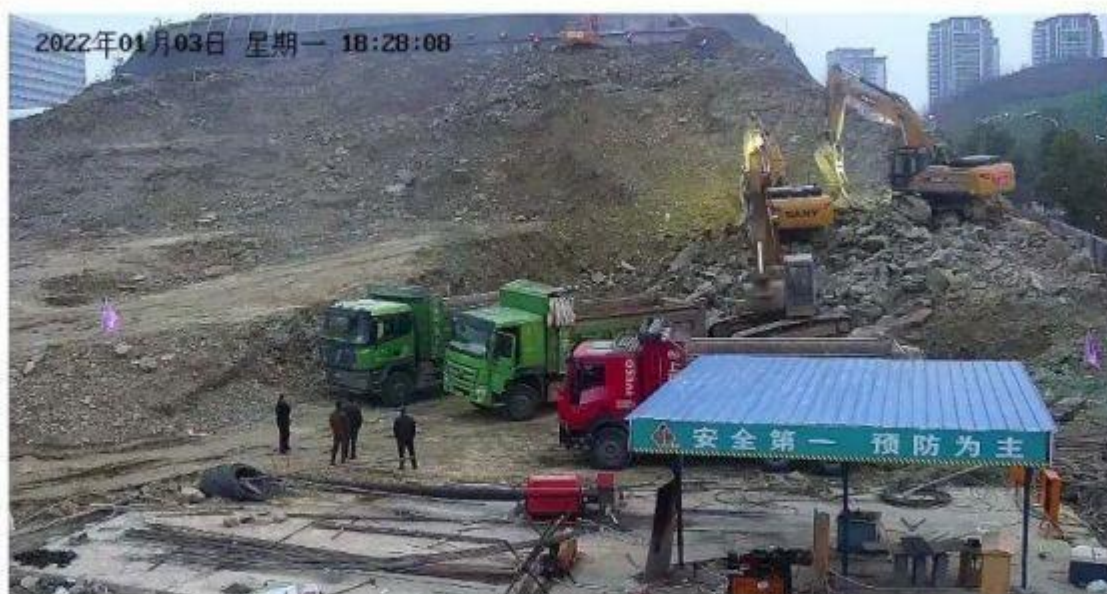
图 2：2022 年 1 月 3 日滑坡前施工现场
