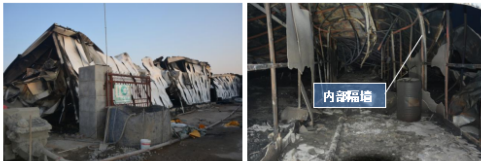
图4、图5 外墙、屋顶和内部隔墙情况
