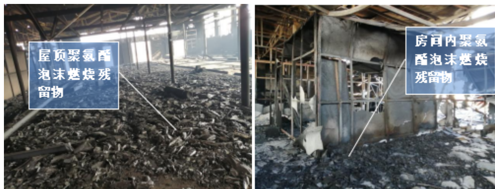
图6、图7 聚氨酯泡沫燃烧产物
