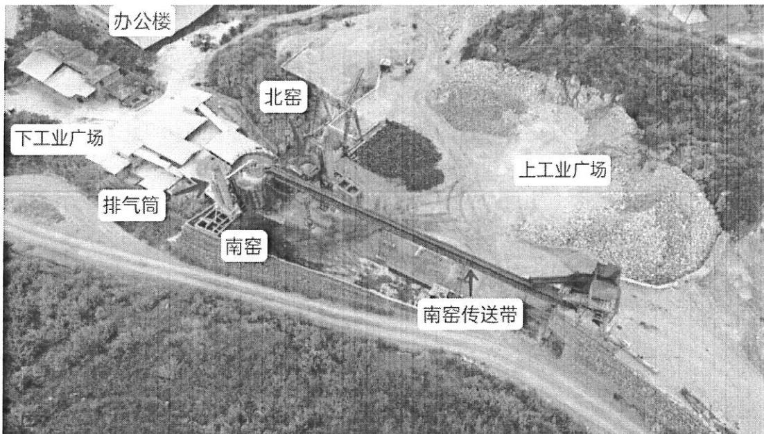
2020年6月，南窑股东以北窑窑烟影响其员工作业为由，同时也为增加产量，不顾北窑股东反对，自行聘请瑞金市云石山乡一泥工对窑体加高5.2米，加高部分为圆柱形，直径5.8米，窑口直径仍为3米，加高工程于8月初完工。8月15日，南窑加料点火，8月30日开始出石灰，至事故时出石灰30余吨。
