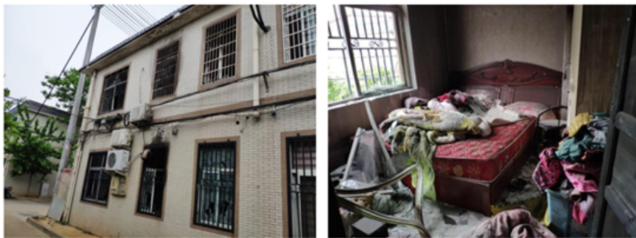
图 7 事故房屋北侧窗户均被安装防盗窗
