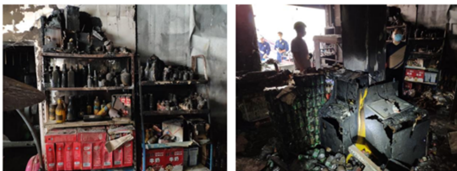
图 8 事故店铺内堆放大量易燃物品
