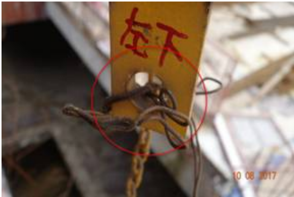
图3-7 左下销操作杆上的滑杆插孔
