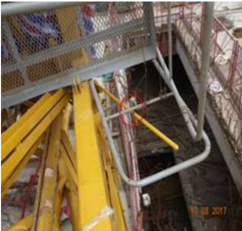
图3-10 右侧顶升销轴辅助连杆装置
