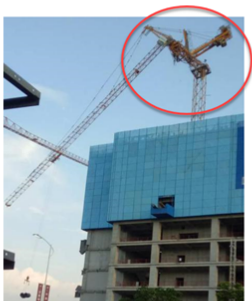
图2-1塔吊倾覆过程中上部宏观结构
