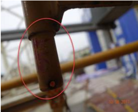
图3-9 换步销操作滑杆安装支座
